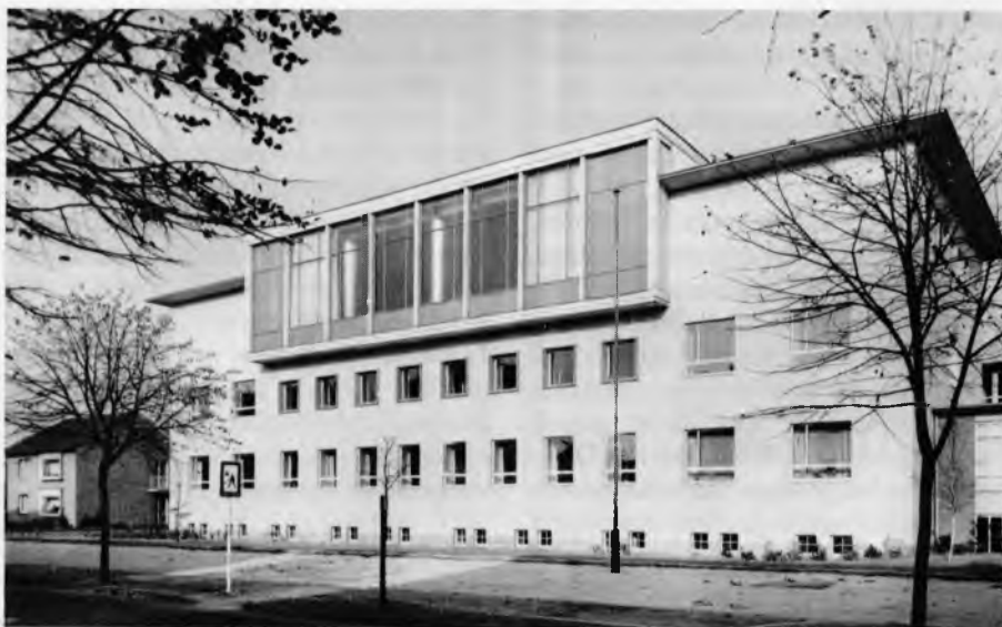
Der umgebaute Altbau an der Bochumer Straße
